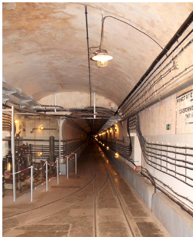
Ligne Maginot : galerie de l'ouvrage du Simserhof
