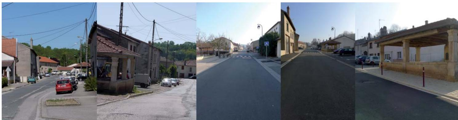
Un appel d'offres est lancé début 2010 pour la rénovation de la rue Franche : enfouissement des réseaux aériens, nouvelles bordures, trottoirs, usoirs, réfection du revêtement de la chaussée, et pour le Revry : revêtement de la chaussée, grilles en travers la chaussée, bas côtés en calcaire.
